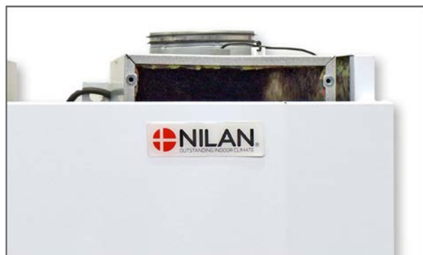
4. Suodatinkammiot on hyvä imuroida suodattimia vaihdettaessa.
