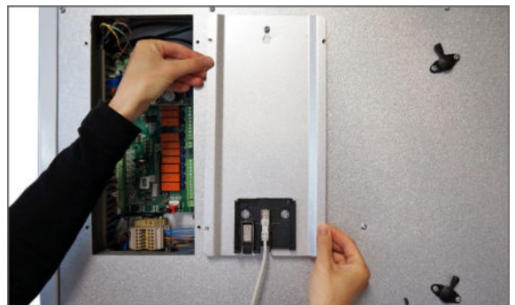
4. Irroita suoja ja ripusta se reiän viereen.
