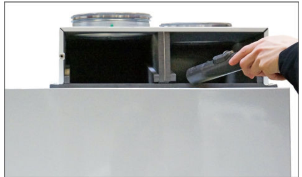
4. Suodatintila kannattaa imuroida ja pouhdistaa sinne kertyneestä pölystä .
