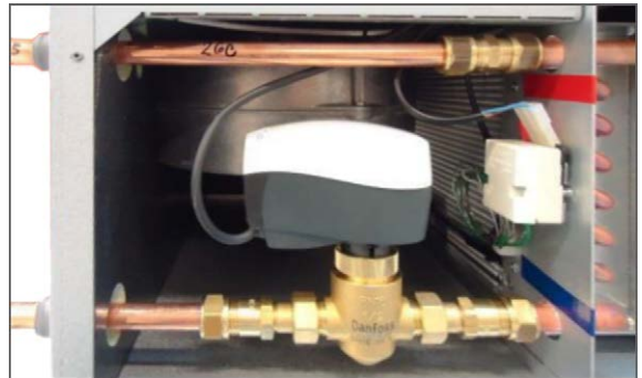
4. Jäätymistermostaatti B3 asennetaan vesipatteriin.
