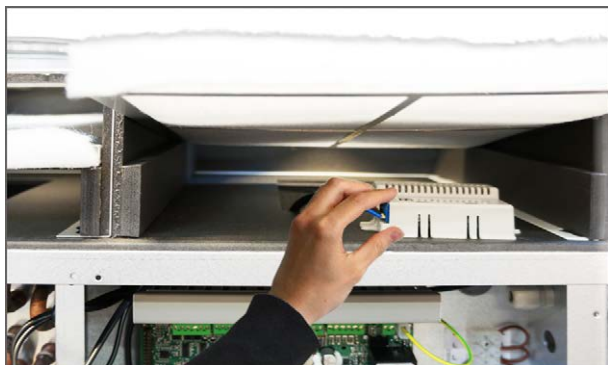
3. Asenna CO 2 anturi poistosuodattimen alla olevalle metallihyllylle itseporautuvilla ruuveilla. (toimitetaan co 2 -anturi paketissa)
