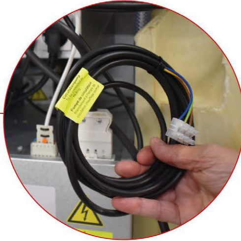
Lämmityspiirin kiertovesipumpun syöttökaapeli
