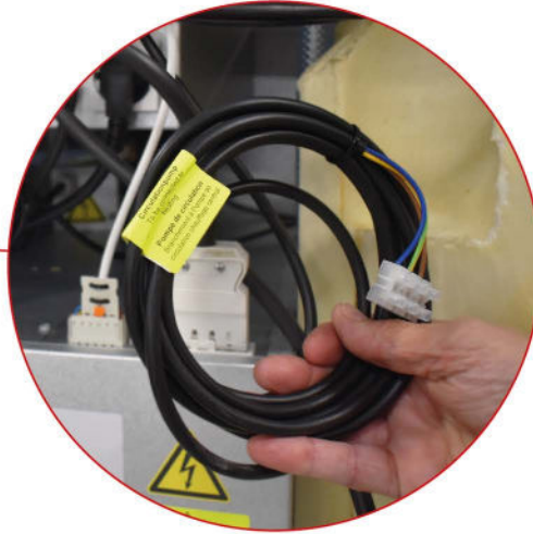
Lämmityspiirin kiertovesipumpun syöttökaapeli
