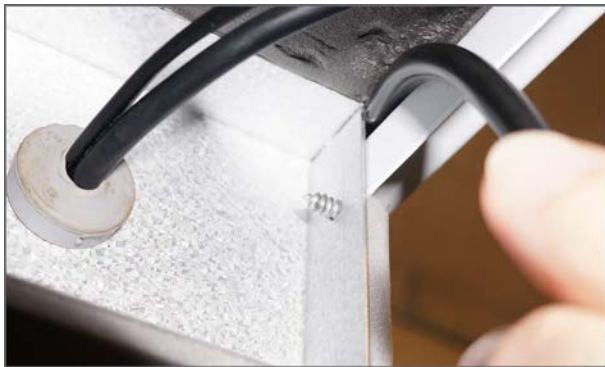
3. Tee reikä ristikkäistuen päällä olevaan eristeeseen (mihin lämmönvaihdin asettuu) jotta pääset yläosan läpivienttiin.
