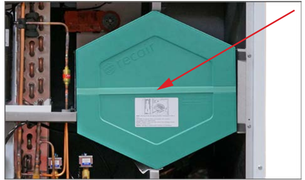
2. Poista lämmönvaihdin vetämällä hinnasta (älä katkaise)
