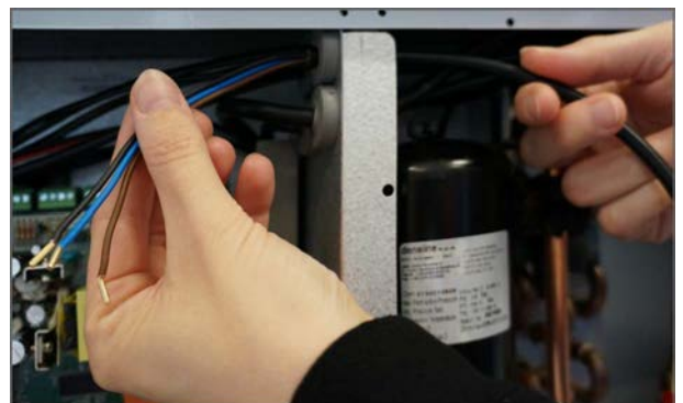
6. vedä johto anturilta kaapeliläpiviennin kautta automaattikalle. Johto kiinnitetään paikoitellen johtokiinnikkeillä.
