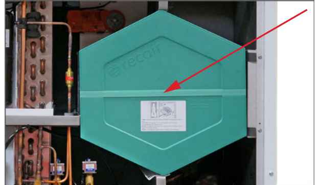
2. Poista lämmönvaihdin vetämällä hihnasta (älä katkaise)
