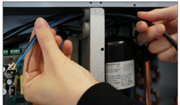
6. vedä johto anturilta kaapeliläpiviennin kautta automatiikalle. Johto kiinnitetään paikoitellen johtokiinnikkeillä.
