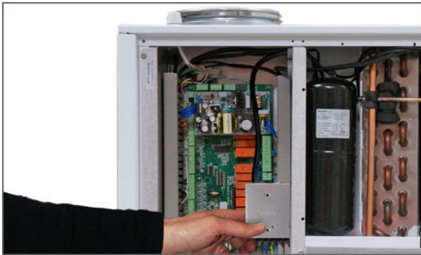
7. Asenna virtalähde automatiikka tilaan. (esiporaa 2 reikää ruuveille).
