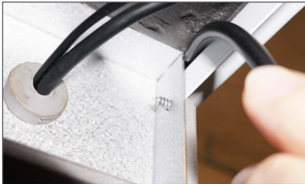
3. Tee reikä ristikkäistuen päällä olevaan eristeeseen (mihin lämmönvaihdin asettuu) jotta pääset yläosan läpivientiin.
