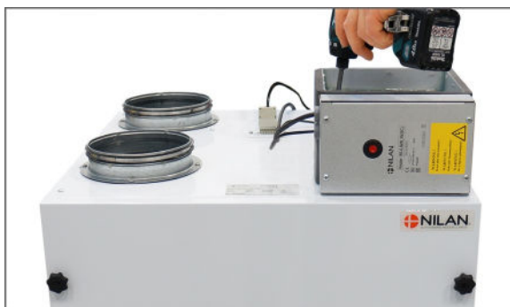
3. Esilämmitin asennetaan raitisilma kanavayhteeseen laitteen päälle tai sivulle (sivulle asennettaessa tulee suojapelti siirtää peittämään laitteen päällä oleva yhde). Asenna lämmitin siten että laitteen ylin etusuojapelti on helposti irrotettavissa.
