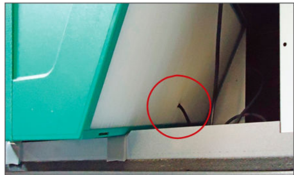
4. Vedä T4 anturi pois lämmönvaihtimesta.
