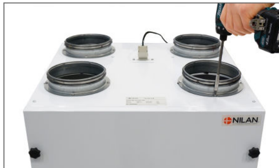
2. Irrota ulkoilman kanavayhde.
