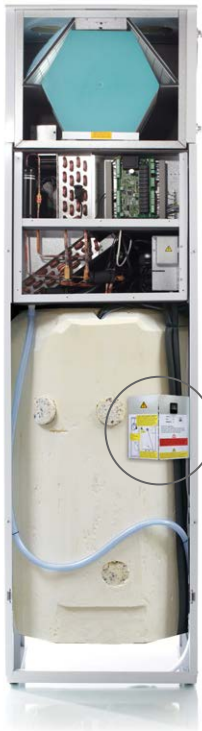
Pakkolämmityskytkin on suuren etupellin takana
