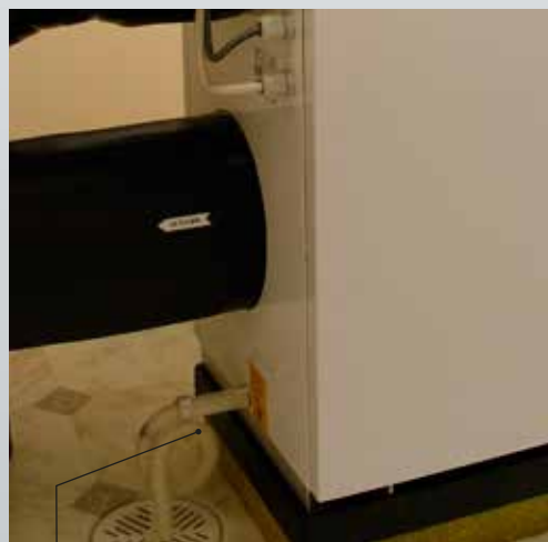
Vesilukko, korkeus on oltava tarpeeksi suuri (padotuskorkeus).
