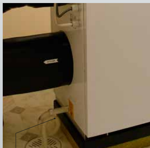
Vesilukko, korkeus on oltava tarpeeksi suuri (padotuskorkeus).
